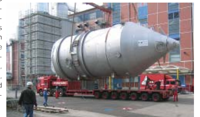
Ein 400-to-Autokran nahm den Behälter an den Haken und hob ihn auf die Montagehöhe von 50 Metern.
