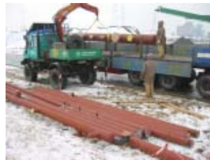
Anlieferung der vorgefertigten Rohrspools
