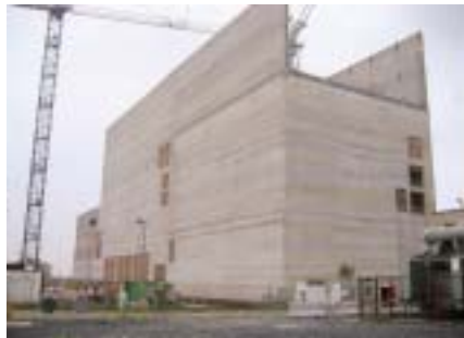
Rohbau der Verbrennungsanlage
