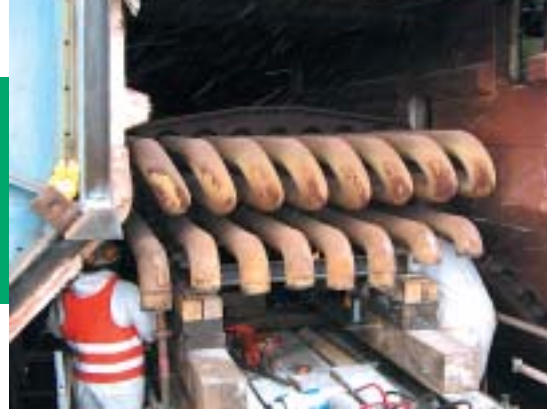
Beengte Verhältnisse bei der Demontage.
