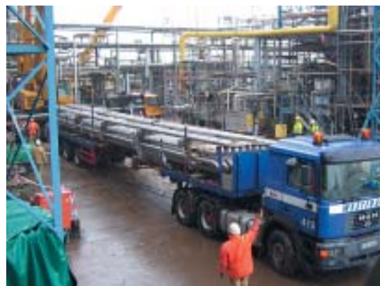
Die vorgefertigten neuen Rohrmatten wurden frühzeitig angeliefert, eingehoben und montiert.
