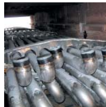
Die vorgefertigten neuen Rohrmatten wurden frühzeitig angeliefert, eingehoben und montiert.
