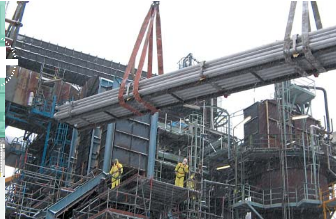
Sicherer Tandemhub des neuen Bündels bei Schneetreiben und niedrigen Temperaturen. Der hohe Vorfertigungsgrad brachte hier einen wesentlichen Anteil an Terminalsicherheit.
