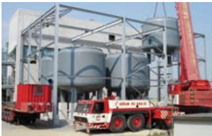
Montage der Filterbehälter.
