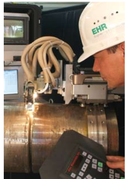
Mit Helm im neuen Design beim Testen der neuen Engspaltschweißanlage in Dortmund.
