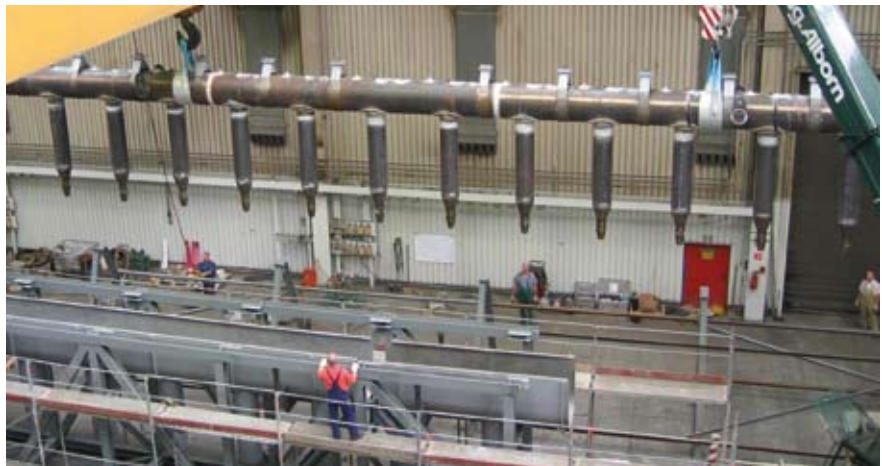
Oben: Ausrichtung und Vermessung der Aufhängungen der Ausflusskammer.
