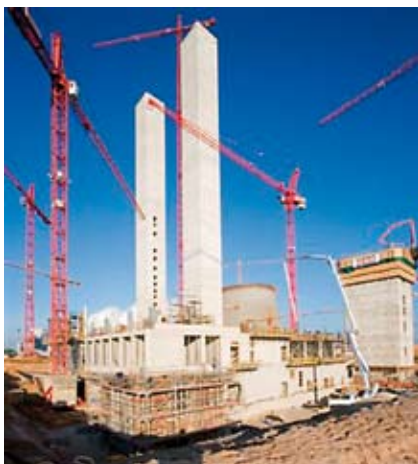
Die imposante Baustelle in Neurath
