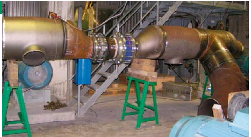
Regelklappe zwischen Niederdruck- und Gemischdampfleitung
